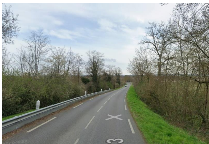
Vue sur le secteur de projet ER14, depuis le Sud Google Maps, mars 2022
